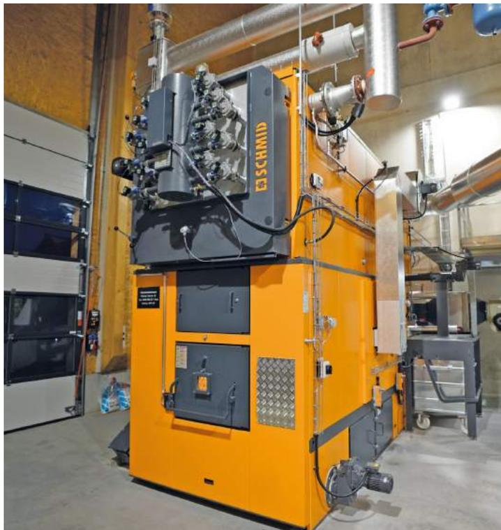
Bild 5 Automatischer Holzheizkessel UTSR-900 des Wärmeverbands Alt St. Johann (SG).
