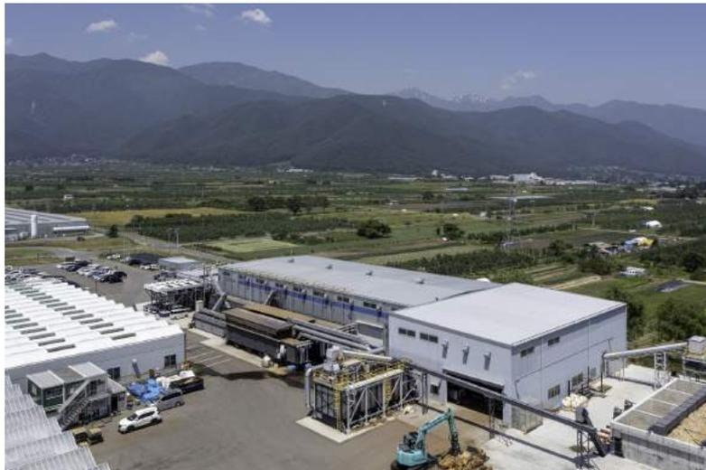
Bild 6 Trigeneration für Tomatenzucht in Asien mit 900 kW<sub>el</sub>, 2 MW<sub>th</sub> und Nutzung des CO<sub>2</sub> aus dem Holzgas zum Tomatenanbau.
