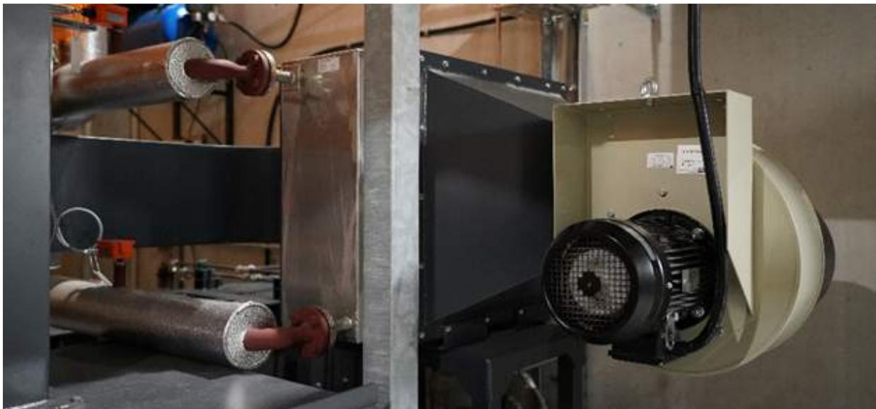
Bild 4 Warmwasser-LuVo mit angebautem Luft-Ventilator an einem Schmid UTSR-900.
