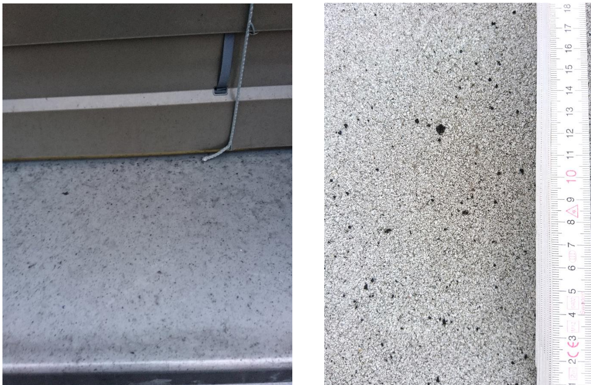
Bild 1 Zwei Beispiele für Ablagerungen in der Umgebung von Holzfeuerungen. Links ein Fensterbrett mit Grobstaub, der direkt aus der Brennkammer der untersuchten Anlage 2 ausgetragen wurde. Rechts auf dem Dach in der Nähe des Kamins der Waldhackschnitzelfeuerung des Versuchslabors an der HSLU, Grobstaub der bei schlechtem Betrieb der Anlage als agglomerierter Russ aus dem Elektroabscheider ausgetragen wurde.
