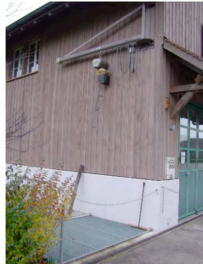
Kranvorrichtung für Aschecontainer
