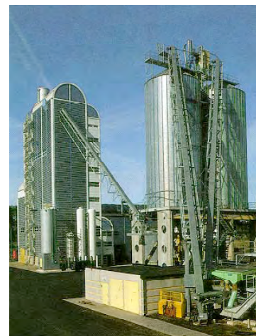
Bild 23 IGCC-Demonstrationsanlage mit Druckvergasung in einer zirkulierenden Wirbelschicht in Värnamo (Schweden) [Stahl und Nehrgard 1996 und 1998]. Vergasungsdruck: 25 bar, elektrische Leistung Gasturbine 4 MW, Dampfturbine 2 MW, Fernwärmeauskopplung maxi-
