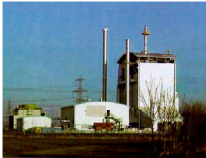
Bild 24 IGCC-Anlage mit atmosphärischer Vergasung und katalytischem Teercracker (Projekt ARBRE, UK; Prozess TPS, [Hallgren 2001]).
