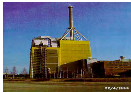
Bild 22 Wirbelschichtvergaser für Zufeuerung in Kohlestaubkraftwerk in Lahti (Finnland), Leistung Biomasse 40–70 MW, Foster Wheeler [Nieminen 1998].
