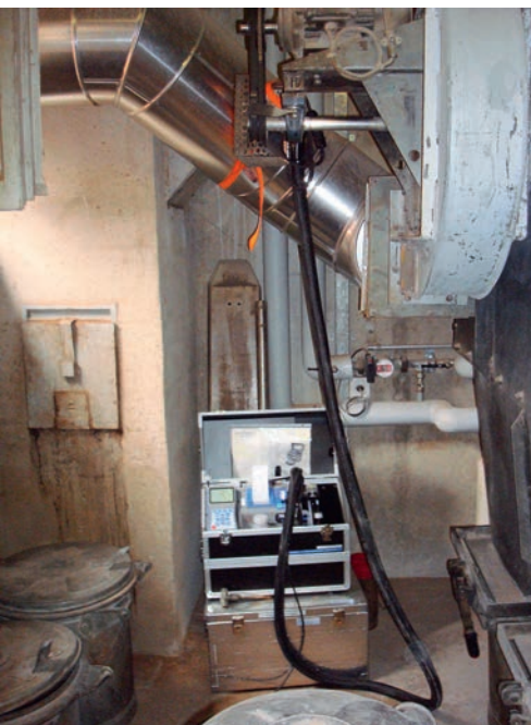
Abgasmessung im Kamin einer automatischen Holzfeuerung.
