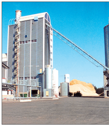
Abbildung 1 Deomonstrationsanlage des Holzgas-Kombikraftwerks in Värnamo (Schweden) [4].
